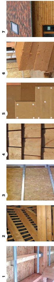
1. Ossature bois | 2. Bardage | 3. Panneaux OSB | 4. Tuile de bois | 5. Isolant : panneaux de fibre de bois (rigide) | 6. Isolant : laine de bois (souple) | 7. Bardage
